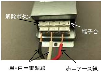
●LED電源ユニットの取扱説明書に従って電源線を接続してください。
